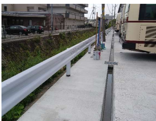
有栖川車庫転落防止ガードレールの設置
