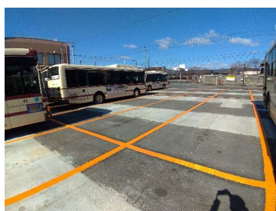
高野車庫内路面補修並びに枠線再塗装
