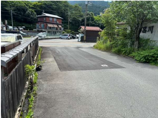
大原 BT 路面補修(入口側)
