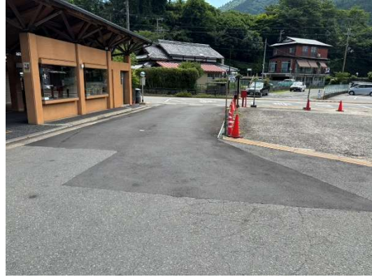
大原 BT 路面補修(出口側)
