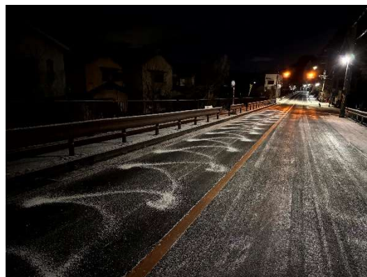
融雪剤散布機及び手撒きによる凍結危険個所の融雪剤散布
